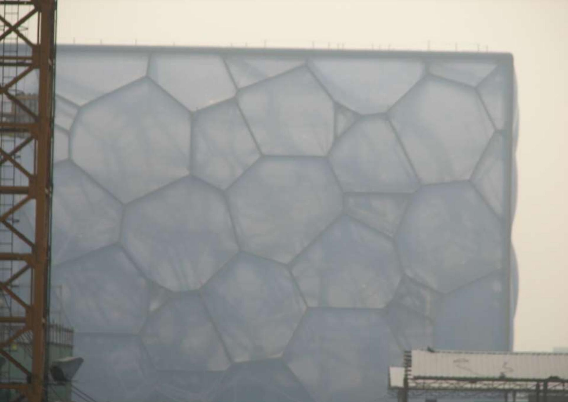
長軸:332.3m 短軸:296.4 全手溶接、主架構板厚110mm以上
