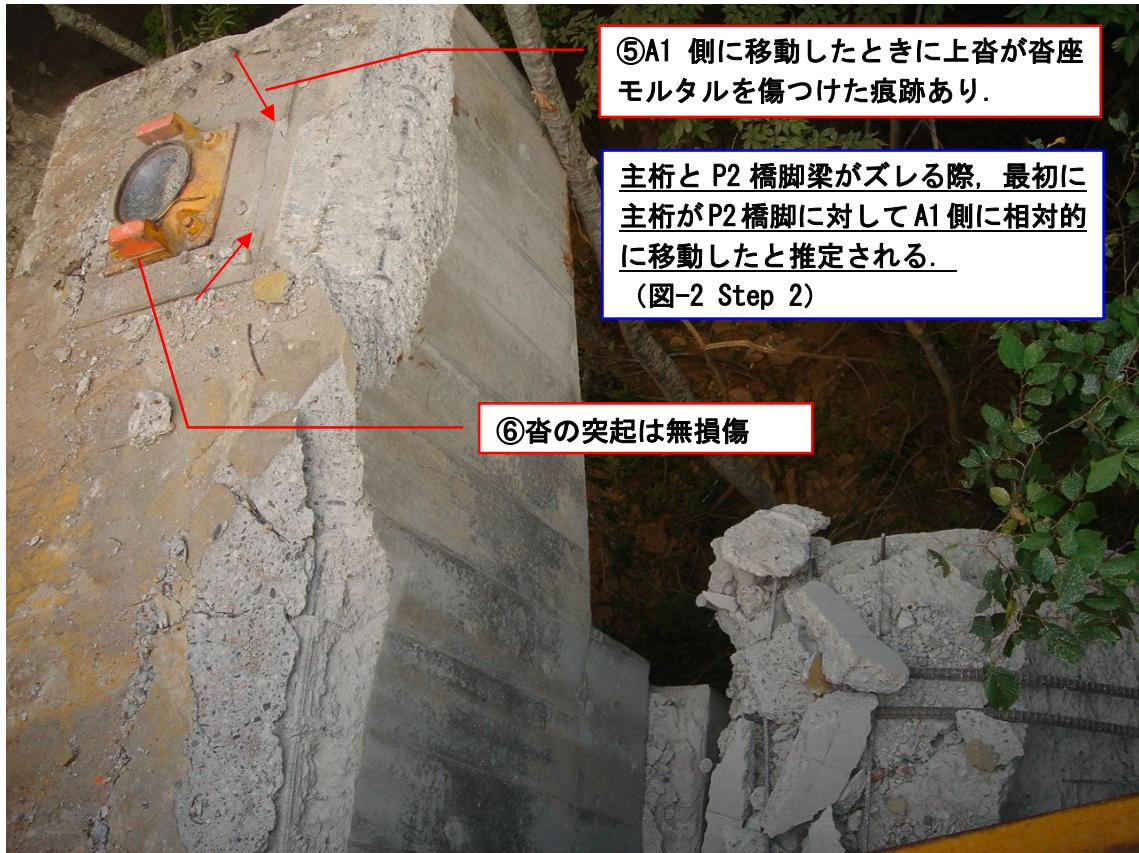
写真-4 P2 支承下流側と沓座面
