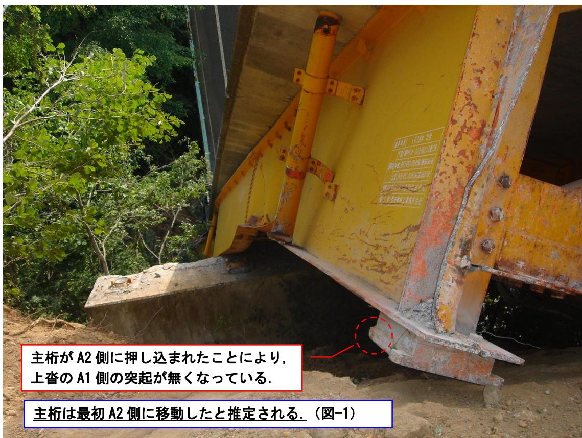
写真-1 下流側外桁のA2支承
