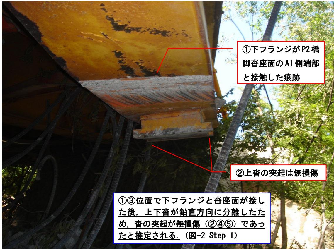
写真-2 下流側外桁の P2 支承と下フランジ
